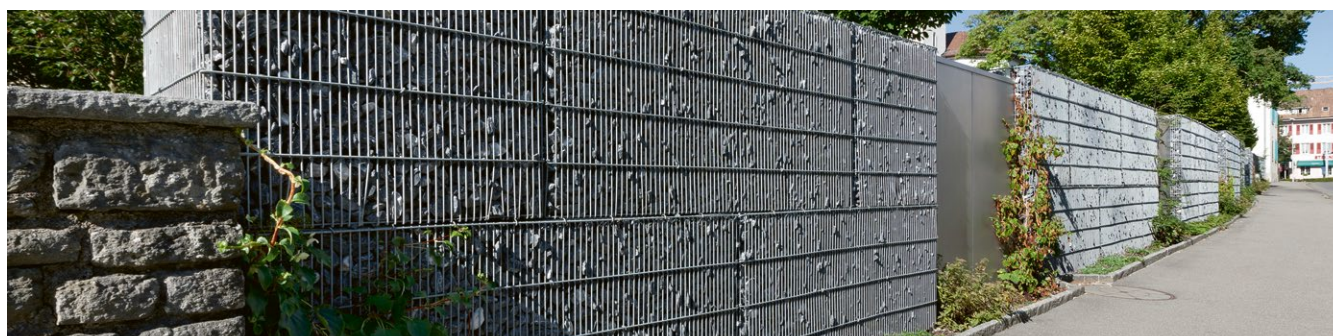
Lärmschutzwand, Füllung Alpenkalk schwarz-weiss
