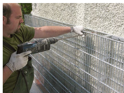
Montage Fassadenkörbe
