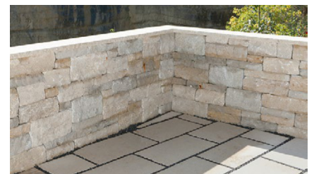
Römermauerwerk Kalkstein
